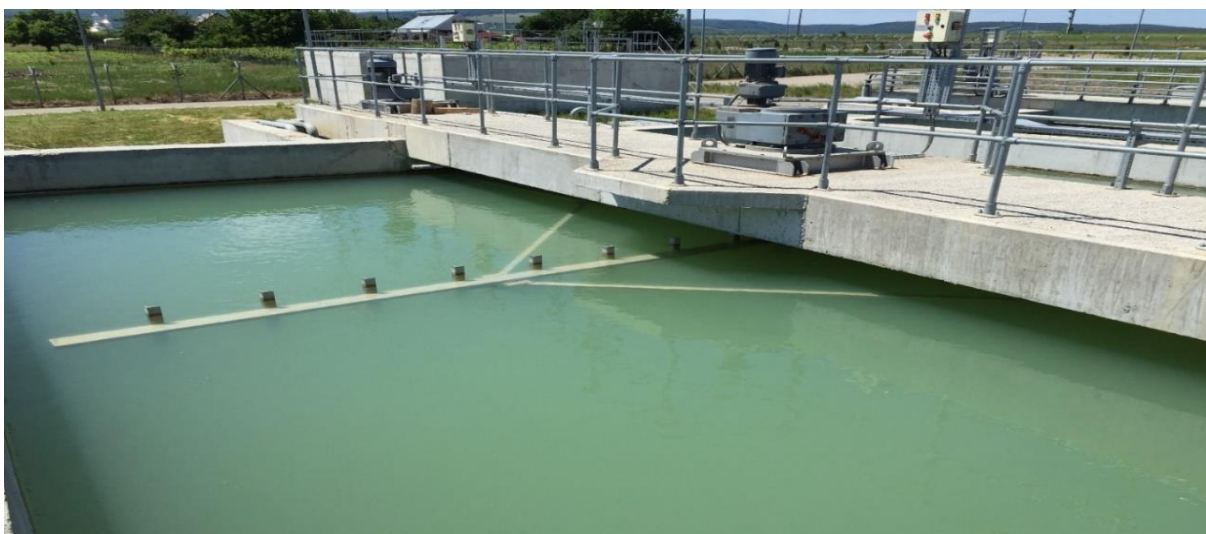
Fig. 12. Bazinul de amestecare (floculator).
