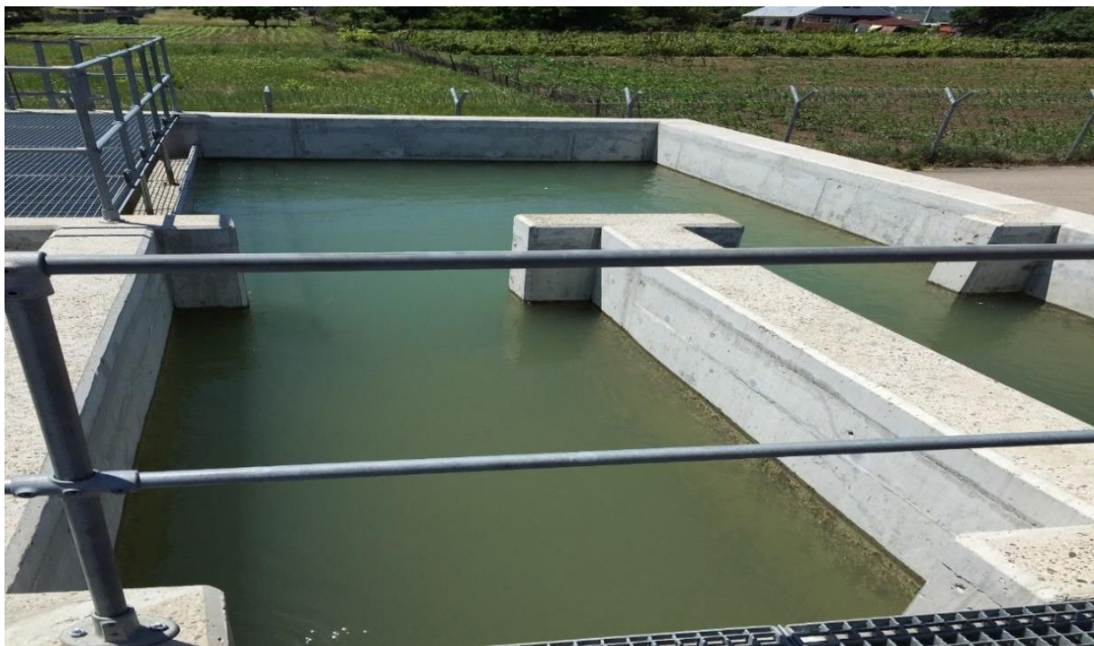
Fig. 11. Deversor orizontal în stația de tratare Barați, Bacău.
