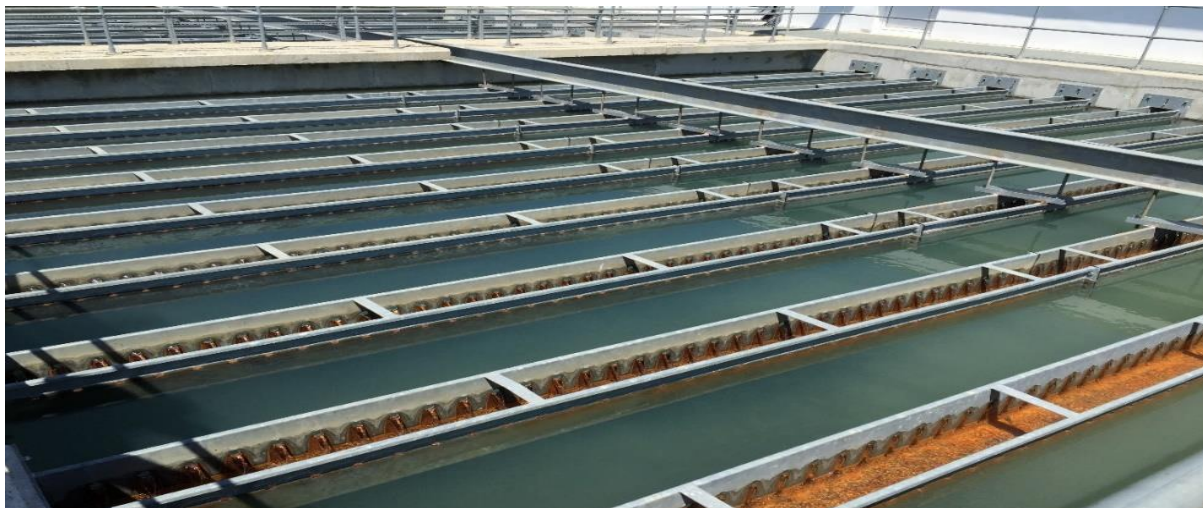
Fig.13. Decantorul lamelar al apei.
